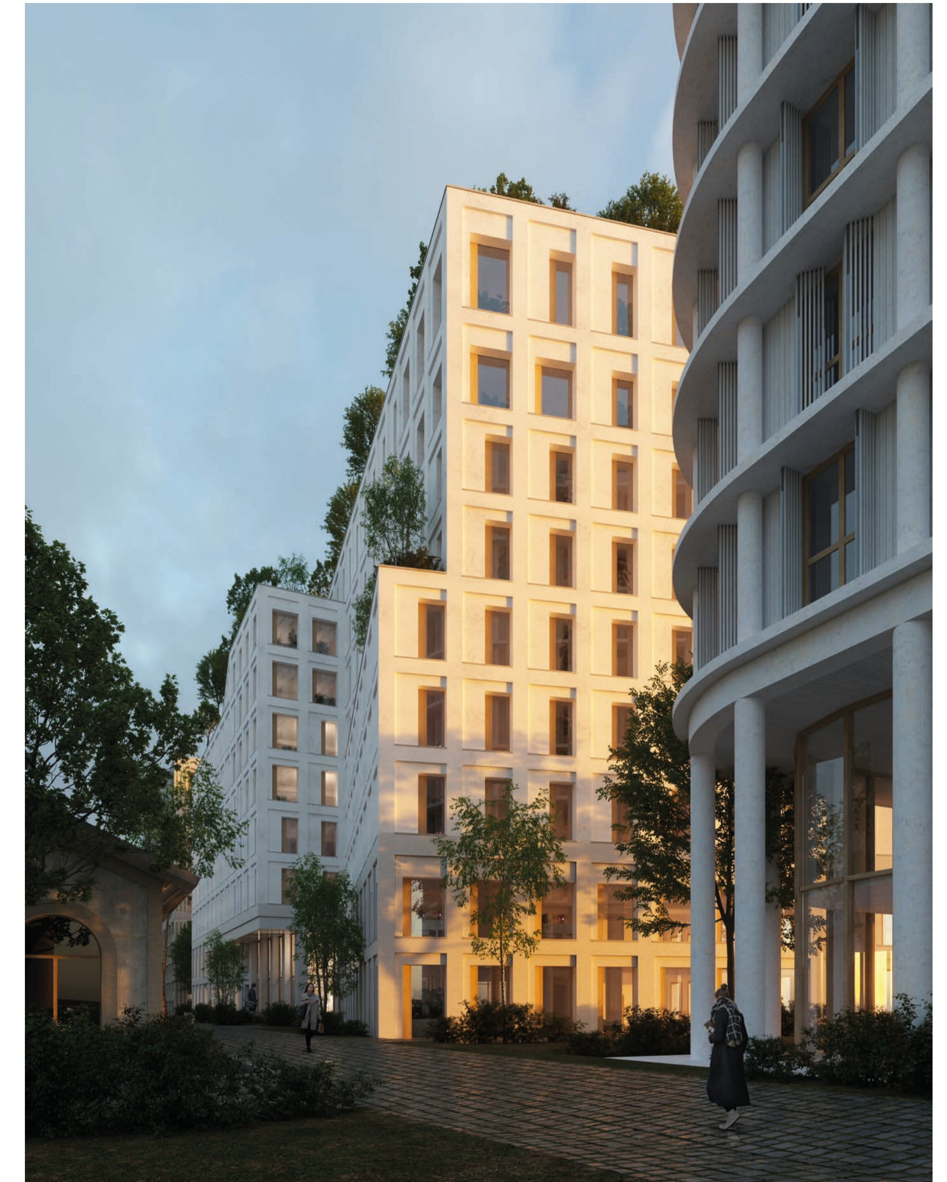
Vue du Bâtiment 9.42 depuis la promenade des Cheminots. 2024 © Baumschlager Eberle Architekten
