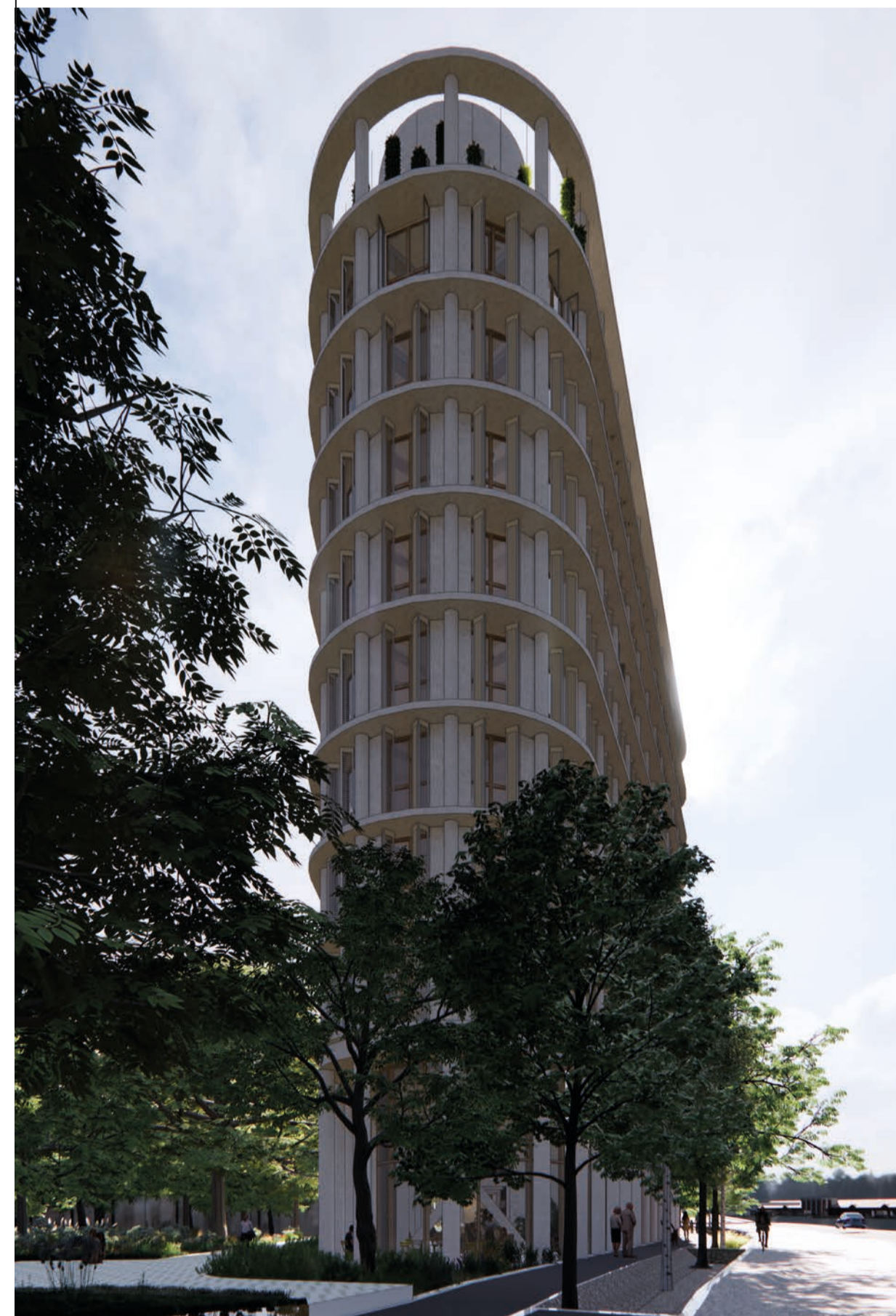
Le socle du bâtiment sera composé de locaux commerciaux et de locaux vélos en rez-de-chaussée et au premier étage. © Nadau Architecture
